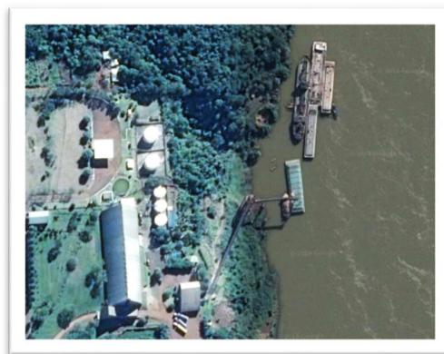
FIGURA 7: Puerto 3 Fronteras (km 1.928)
