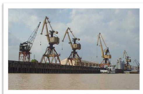
FIGURA 18: Puerto Barranqueras (km 1.848)
