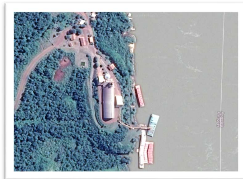
FIGURA 9: Puerto 2 Fronteras (km 1.808)
