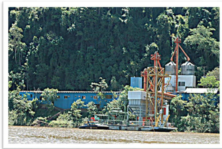
FIGURA 25: Atual infraestrutura do porto fluvial de Foz do Iguaçu
