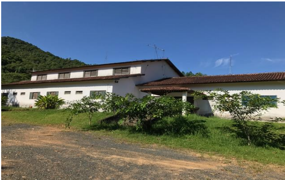
FIGURA 14 - POUSADA DA COMUNIDADE DE IVAPORUNDUVA FONTE: Arquivo da autora (2017).
