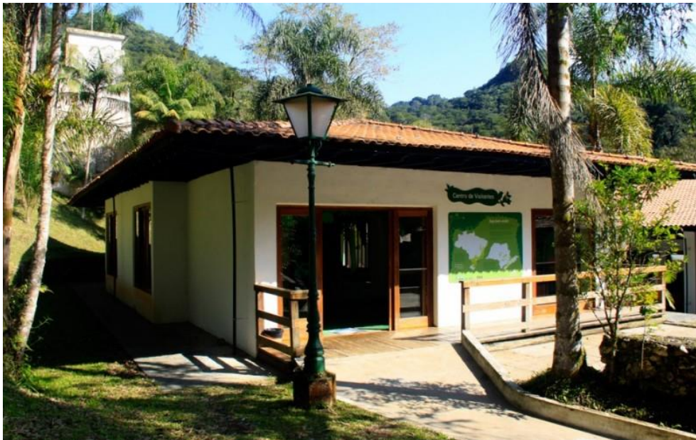
FIGURA 11. CENTRO DE VISITANTES FONTE: http://goo.gl/QGfyrb (2016).
