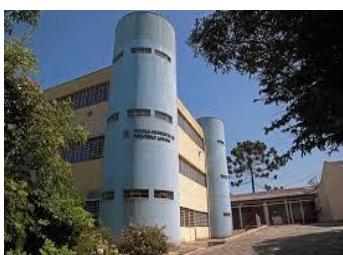
FIGURA 16 – VISTA EXTERNA ESCOLA 3
