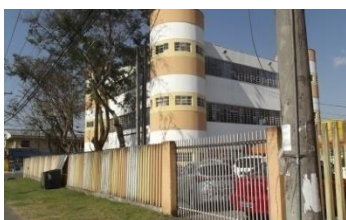
FIGURA 10 – VISTA EXTERNA ESCOLA 2
