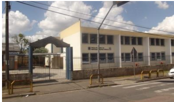
FIGURA 22 – VISTA EXTERNA ESCOLA 4
