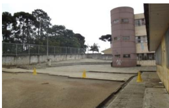
FIGURA 4 – VISTA EXTERNA ESCOLA 1
