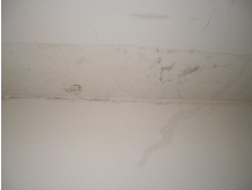
Figura 10 – Forro com Infiltração Fonte: Unidade de Administração de Pessoas – HC-UFPR
