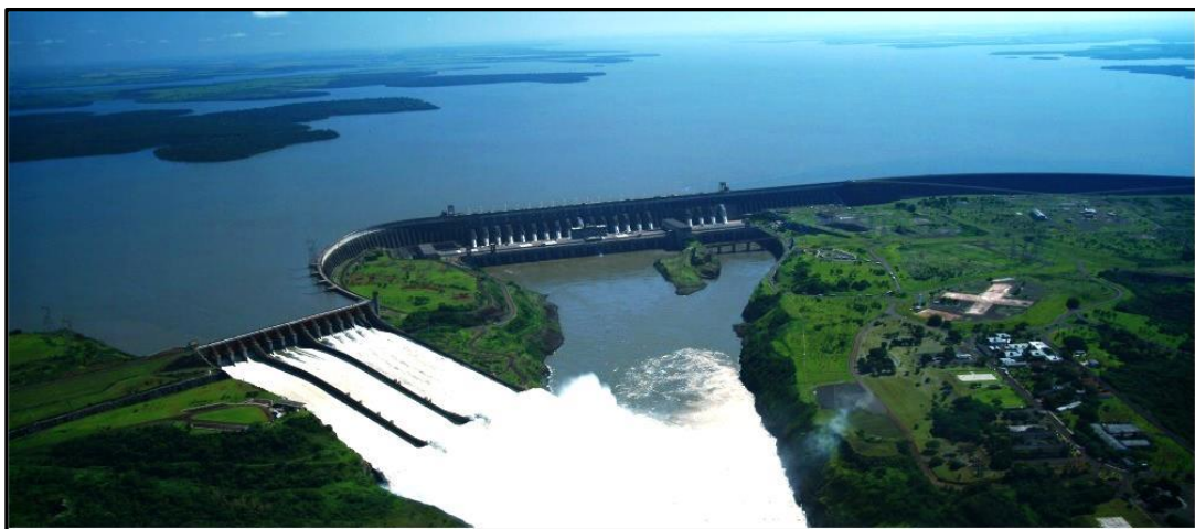
Figura 21 – Vertedouros em operação na usina de Itaipu (ITAIPU, 2015).
