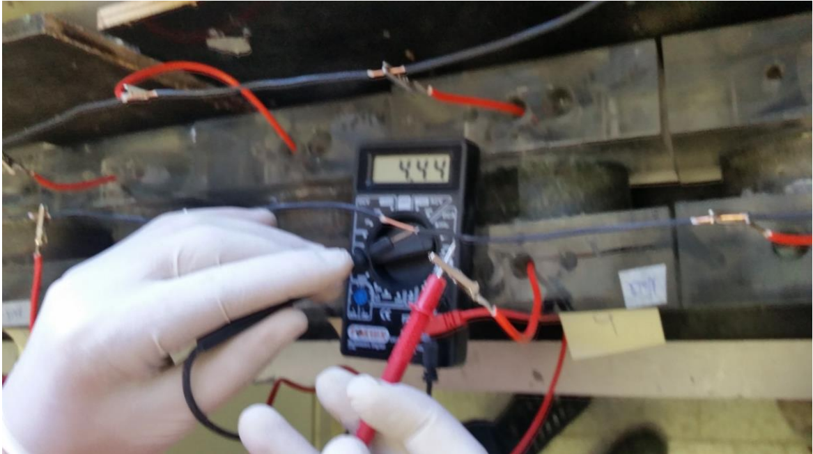
FIGURA 31 - VOLTAGEM APLICADA PARA ENSAIO DE PENETRABILIDADE
