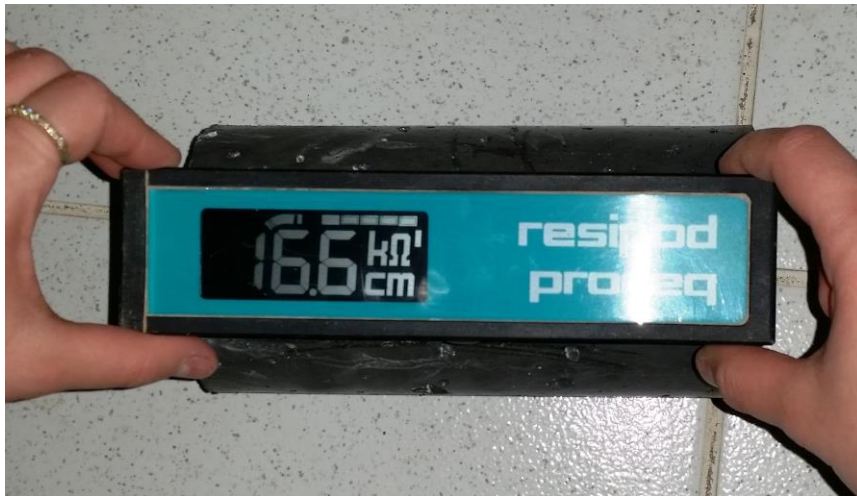
FIGURA 4 – ENSAIO DE RESISTIVIDADE COM EQUIPAMENTO RESIPOD
