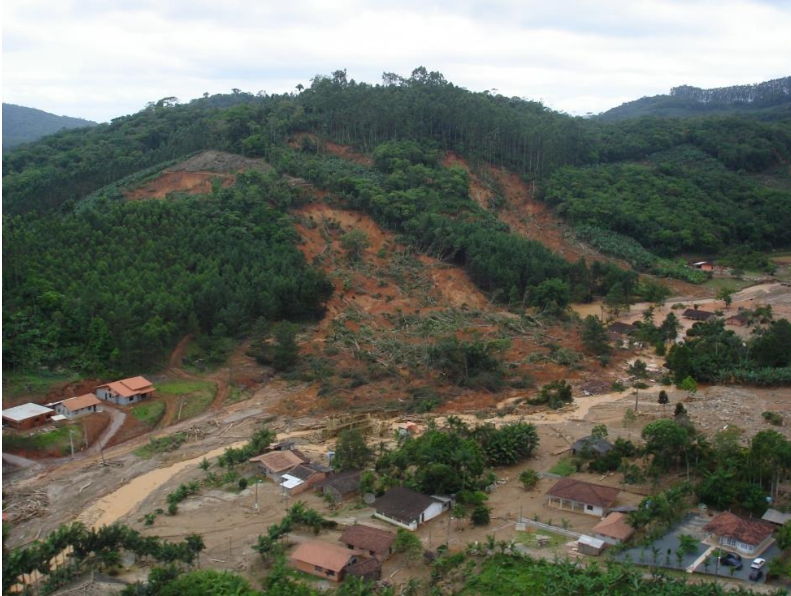
Figura 29: Deslizamentos e enxurrada no Morro do Baú.
