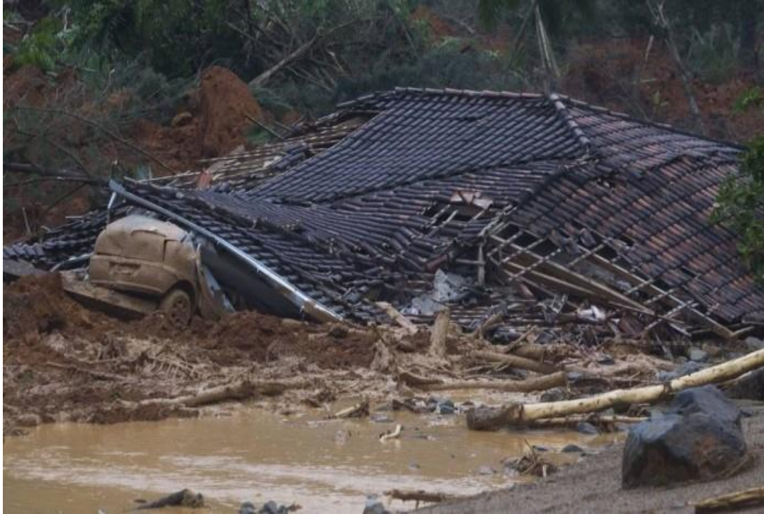
Figura 27: Deslizamentos e Enxurrada no Morro do Baú.
