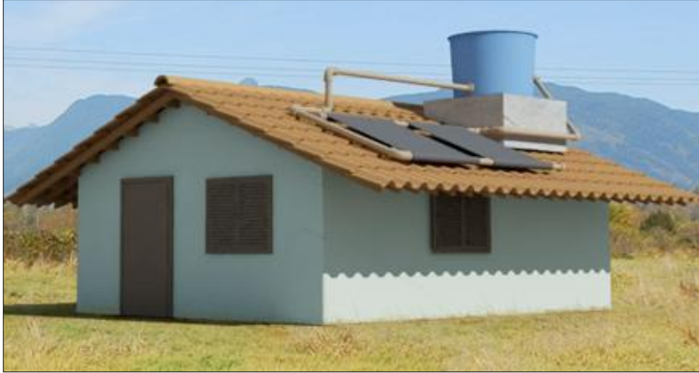
FIGURA 28: UM SISTEMA DE AQUECIMENTO SOLAR DE BAIXO CUSTO FONTE: http://www.sociedadedosol.org.br (SOSOL).
