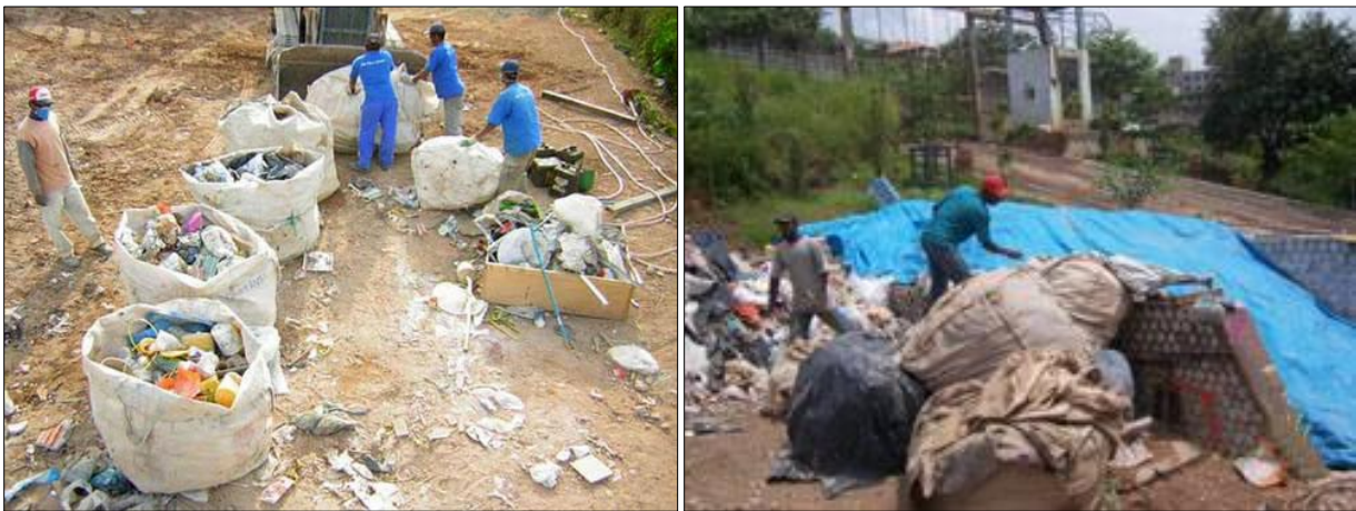
FIGURA 36: TRIAGEM DE RESÍDUO DA CONSTRUÇÃO CIVIL
