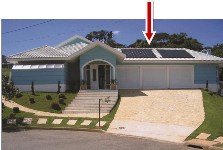
FIGURA 23: EXEMPLO DE APLICAÇÃO DE UM COLETOR DE SUPERFÍCIE PLANA FONTE: www.soletrol.com.br (SOLETROL, 2011).
