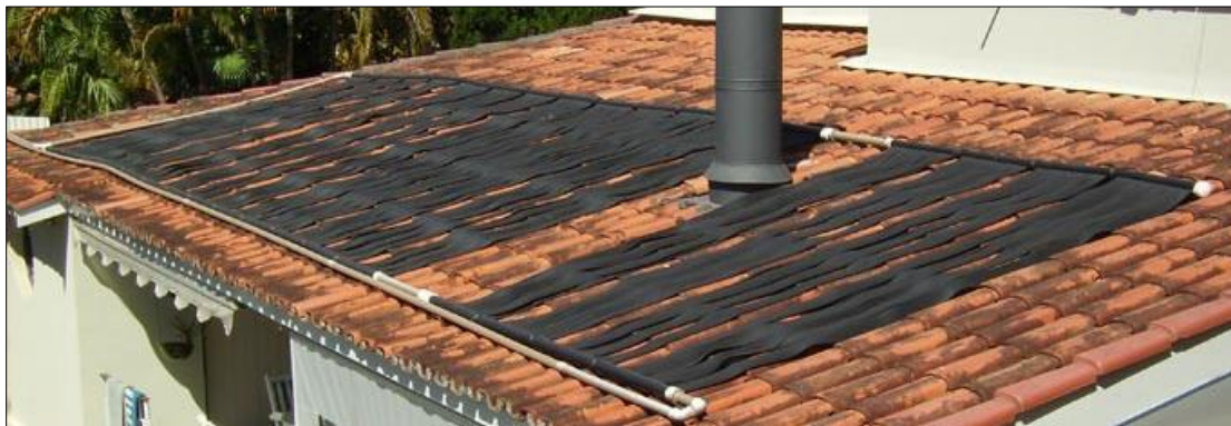
FIGURA 27: EXEMPLO DE APLICAÇÃO DE MANTA SOLAR
