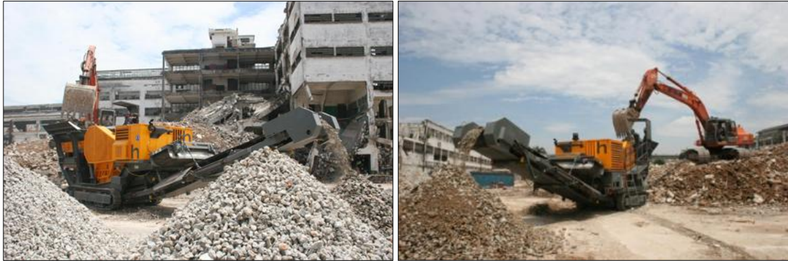
FIGURA 35: RECICLADOR MÓVEL DISPONÍVEL NO MERCADO, USADO PARA PREPARAR OS RESÍDUOS DE DEMOLIÇÃO. O RESULTADO DA RECICLAGEM É UM MATERIAL QUE PODE, EM MUITOS CASOS, CUMPRIR AS FUNÇÕES DA BRITA, SENDO REUTILIZADO NA PRÓPRIA OBRA PARA ATERROS, REFORÇO DE SUBLEITO E CONSTRUÇÃO DE SUB-BASE DE PAVIMENTAÇÃO FONTE: http://www.craftengenharia.com.br/
