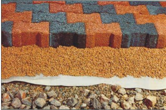
FIGURA 4A (DA ESQUERDA): PAVIMENTO PERMEÁVEL EM BLOCOS INTER-TRAVADOS FONTE: SILVEIRA (2001). FIGURA 4B (DA DIREITA): DETALHE “CONCREGRAMA” FONTE: REIS et al. (2002).
