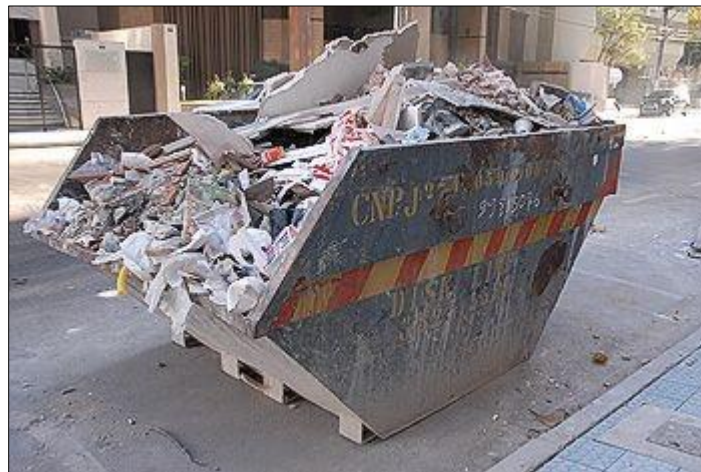
FIGURA 34: IMPACTO NEGATIVO - ENTULHOS DA CONSTRUÇÃO CIVIL.
