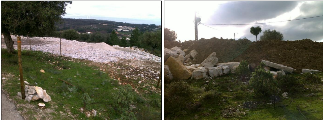
FIGURA 37: DEPOSIÇÃO DE RESÍDUO DA CONSTRUÇÃO CIVIL FONTE: Blog do Covão do Coelho (2010).
