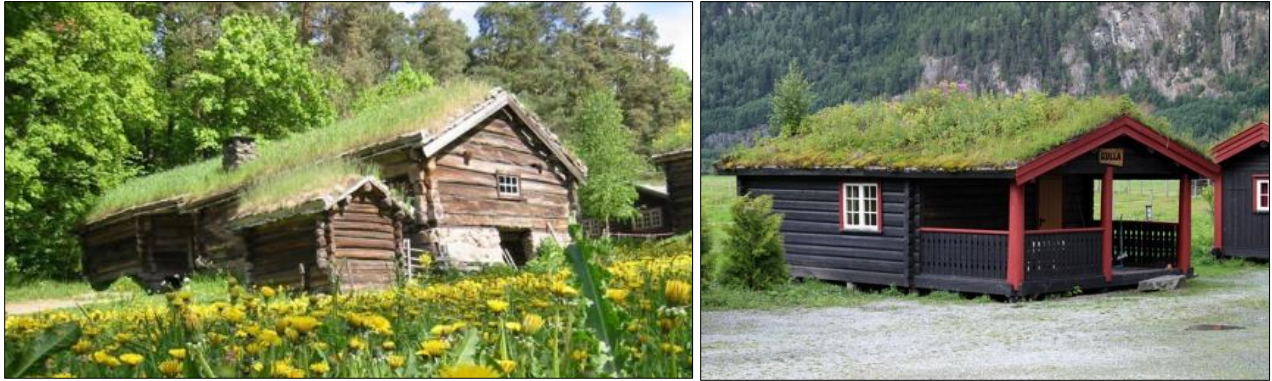
FIGURA 10: COBERTURA VERDE NA NORUEGA
