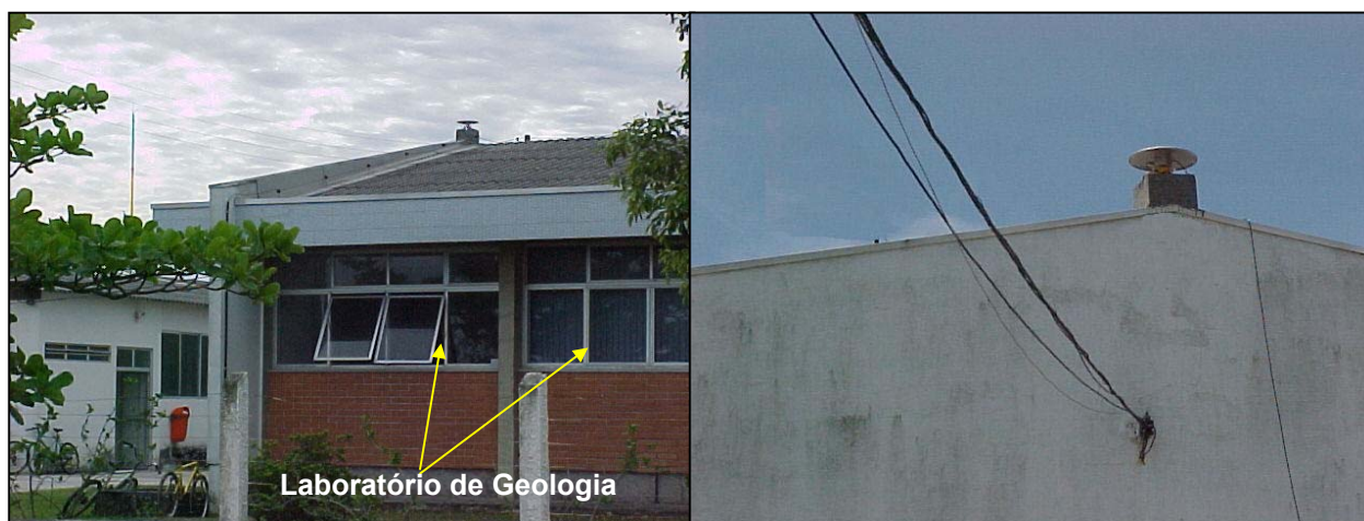
FIGURA 5.3. INSTALAÇÃO DA ANTENA NO CENTRO DE ESTUDOS DO MAR (CEM/UFPR)
