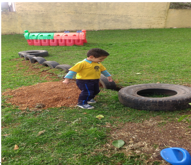
Figura 6: Início da construção do parque de pneus
