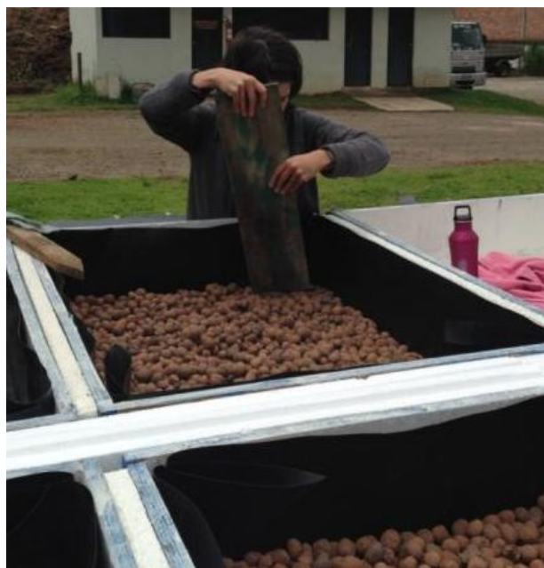
figura 53 - Colocação de argila expandida nos módulos de telhado verde Fonte: A autora (2013)
