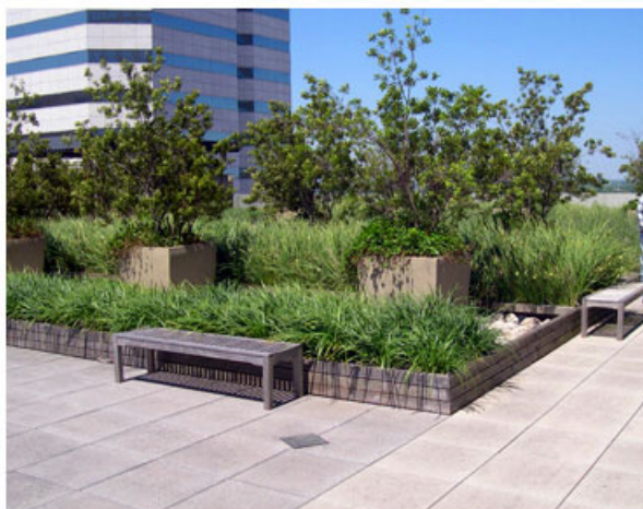
figura 5 - Exemplo de telhado verde de uso intensivo - Houston, USA Fonte: GREEN ROOF TECHNOLOGY (2012)
