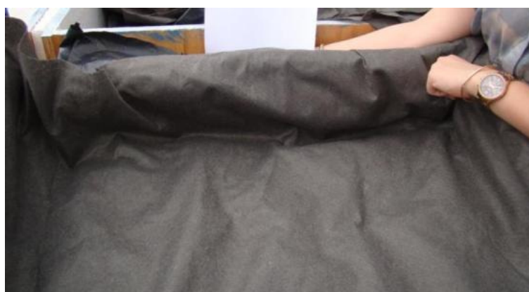
figura 54 - Colocação da manta geotêxtil Fonte: A autora (2013)
