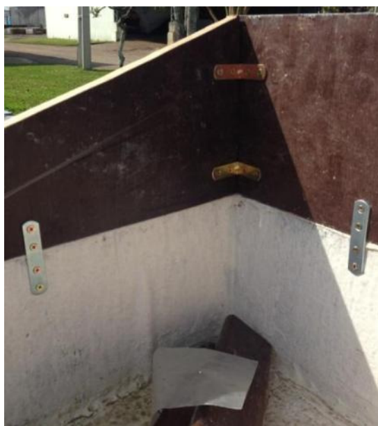
figura 70 - fixação de chapa de compensado Fonte: A Autora (2014)
