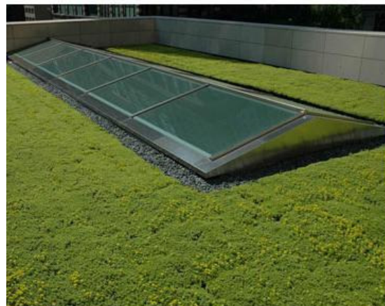
figura 8 - Exemplo de cobertura de uso Extensivo - Chicago USA Fonte: GREEN ROOF TECHNOLOGY (2012)
