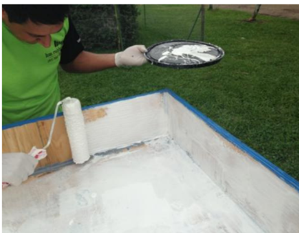
figura 49 - Impermeabilização fundo do protótipo Fonte: A autora (2013)
