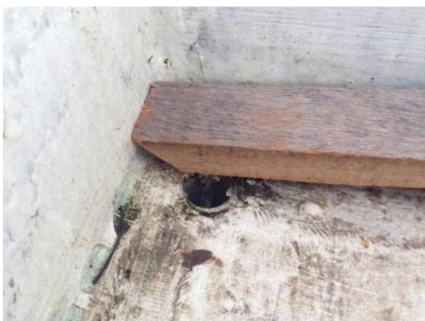
figura 73 - Detalhe do ralo, módulo telhado de fibrocimento Fonte: A Autora (2014)
