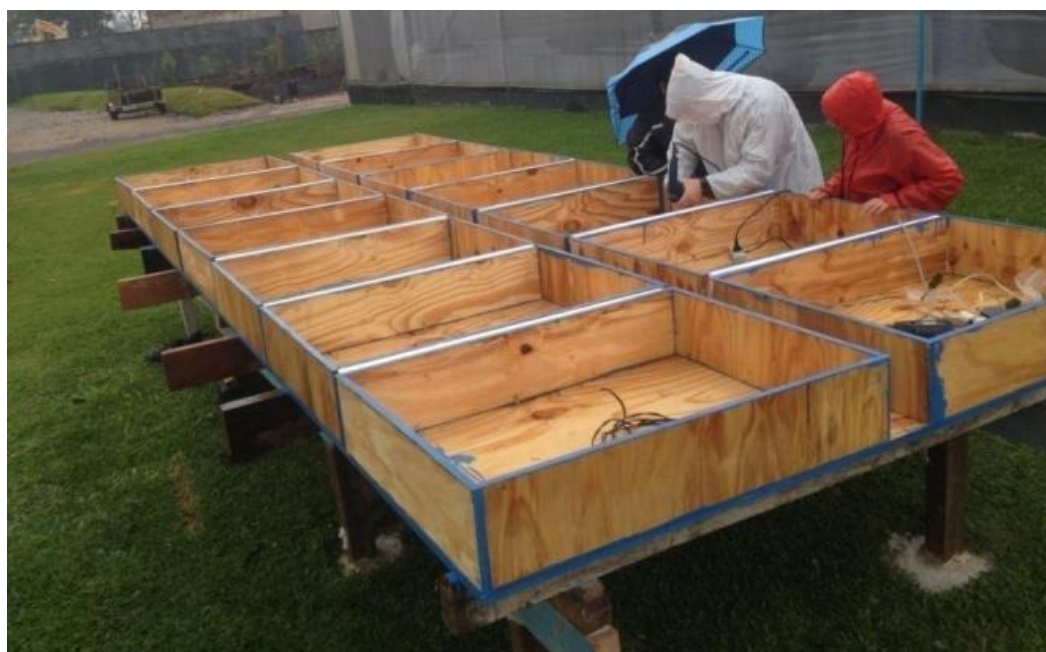
figura 42 - Fixação da estrutura lateral dos módulos Fonte: A Autora (2013)
