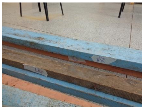
figura 35 - Identificação das vigas e pilares conforme projeto Fonte: A Autora (2013)
