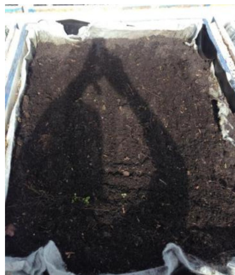
figura 56 - Colocação de substrato no módulo de telhado verde Fonte: A Autora (2014)
