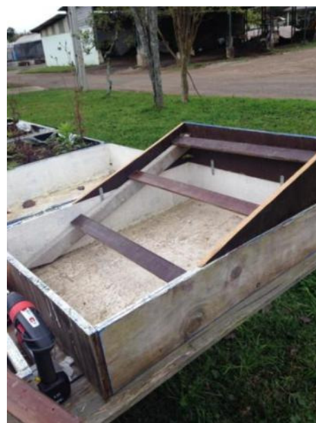
figura 71 - fixação de caibros e ripas para sustentação das telhas cerâmicas Fonte: A Autora (2014)
