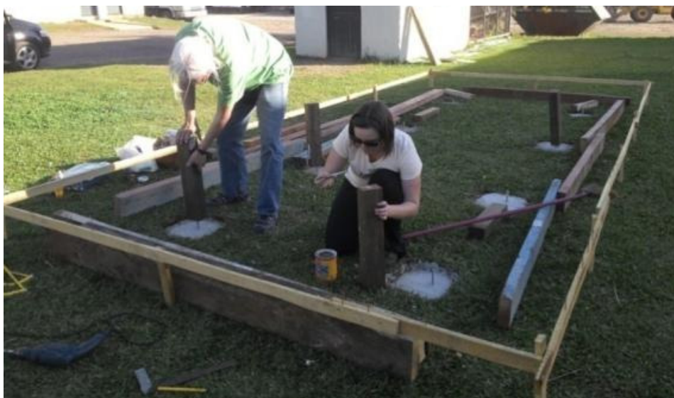
figura 34 - Instalação dos pilares em madeira nas sapatas de concreto Fonte: A Autora (2013)
