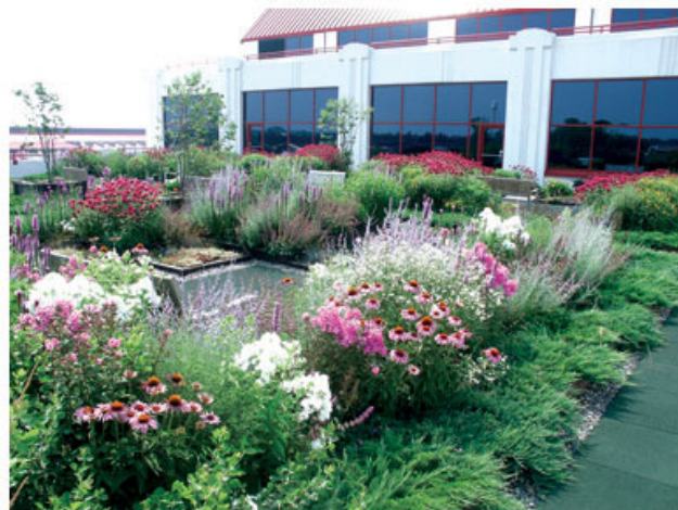
figura 6 - Exemplo de telhado verde de uso intensivo – Beloit, USA Fonte: GREEN ROOF TECHNOLOGY (2012)
