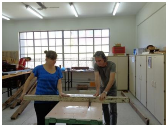
figura 38 - Corte das madeiras conforme projeto Fonte: A Autora (2013)
