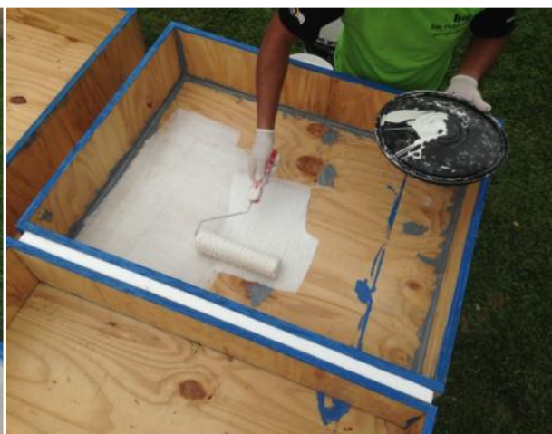
figura 50 - Impermeabilização laterais do protótipo Fonte: A autora (2013)
