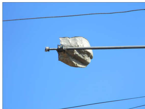
Figura 100 - Fotografias das Condições de Iluminação Pública na Cidade de Francisco Beltrão (PR). (a) Lâmpada sem iluminação no Bairro Vila Nova; (b) Suporte para lâmpada depredado no Bairro Padre Ulrico.
