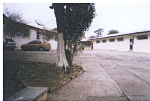
Foto 4- Pátio cimentado, estacionamento
