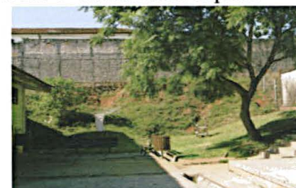
Foto 6 – Pátio e Talude
