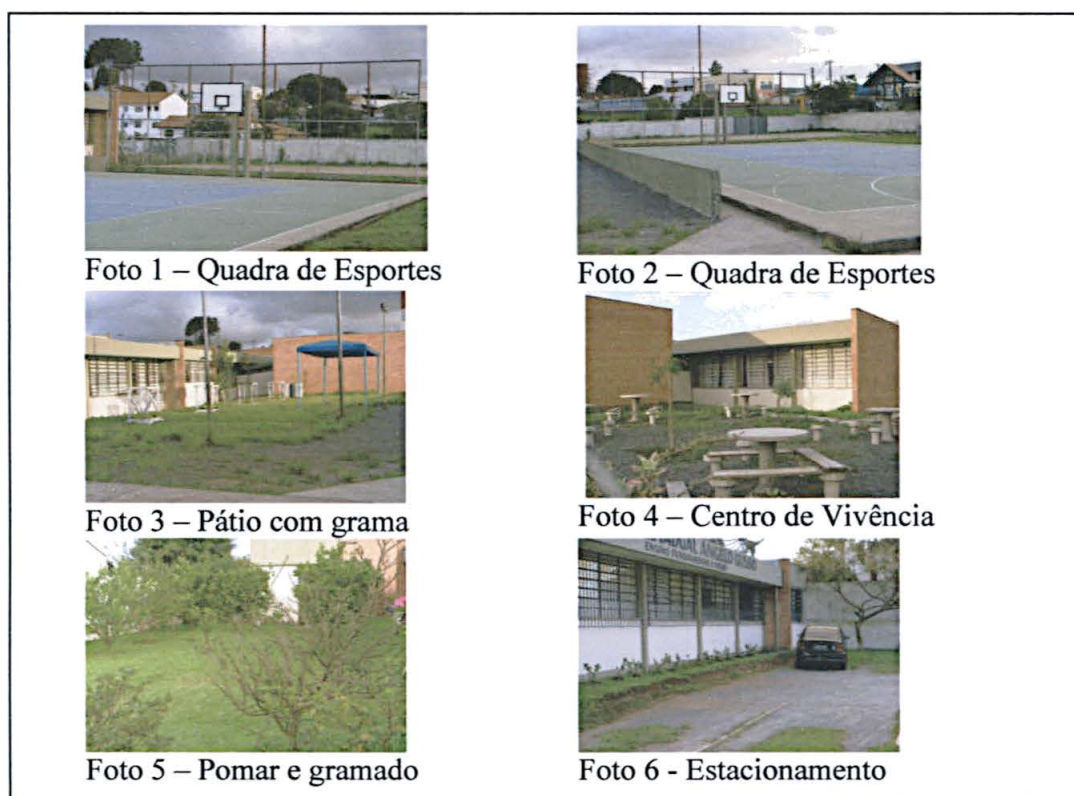
FIGURA 15- VISTAS DA ESCOLA ESTADUAL ANGELO GUSSO
