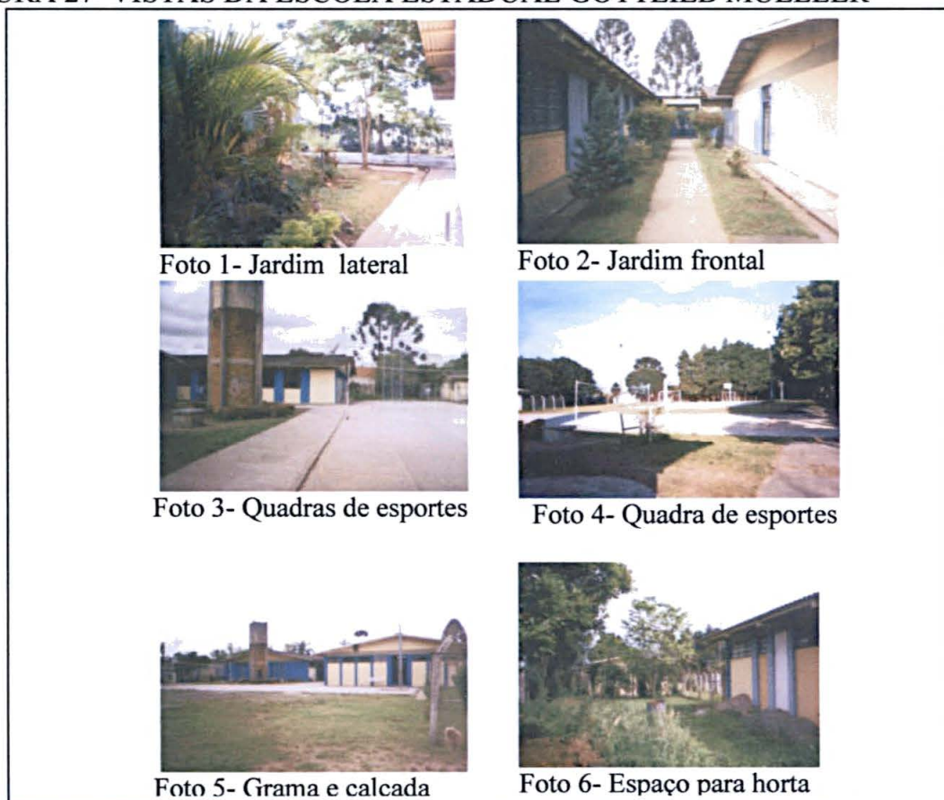
FIGURA 27–VISTAS DA ESCOLA ESTADUAL GOTTLIEB MUELLER
