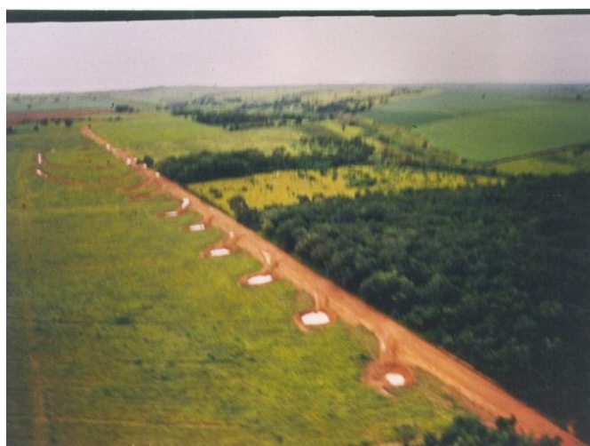
FIGURA 2 - ESTRADA ADEQUADA PARA CAPTAÇÃO CORRETA DE ÁGUAS PLUVIAIS FONTE: Casa da Agricultura Dois Córregos/SP (2001).
