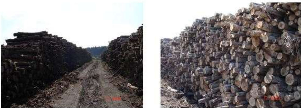
FIGURA 8 – VISTA DO PÁTIO INDUSTRIAL DE MADEIRA PARA ENERGIA
