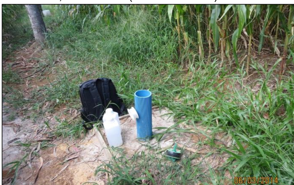
FIGURA 13 – POÇO DE MONITORAMENTO DA QUALIDADE DA ÁGUA SUBTERRÂNEA PM03. 13,70 METROS DE PROFUNDIDADE. LOCALIZAÇÃO UTM: W 595708; S 7221185. (DATUM SAD69)
