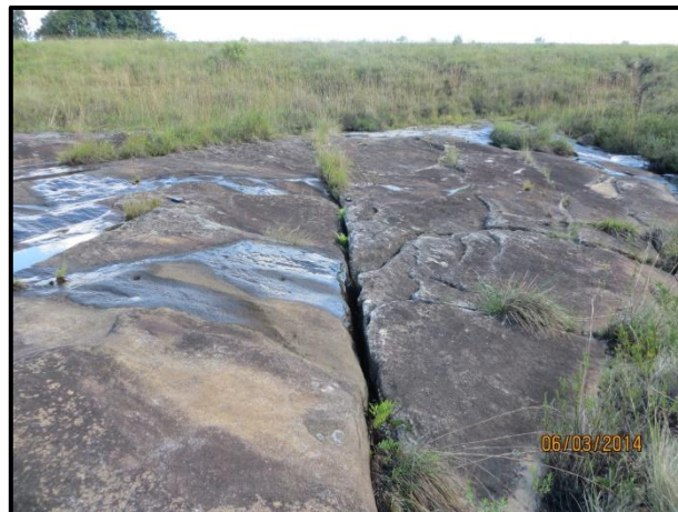
FIGURA 27 – PADRÃO DE FRATURAMENTO OBSERVADO AO LONGO DO ARROIO. FRATURAS VERTICALIZADAS, PAREDES AFASTADAS E COM SENTIDO NE/SW. TAMBÉM GERAM SUMIDOUROS.
