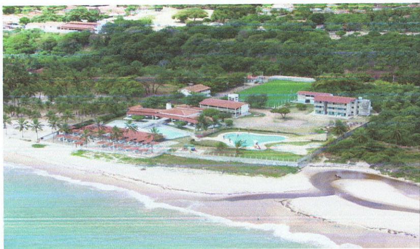
Foto 16: Balneário invadindo área de praia e de preservação permanente na Praia da Penha Fonte: IBAMA/PB
