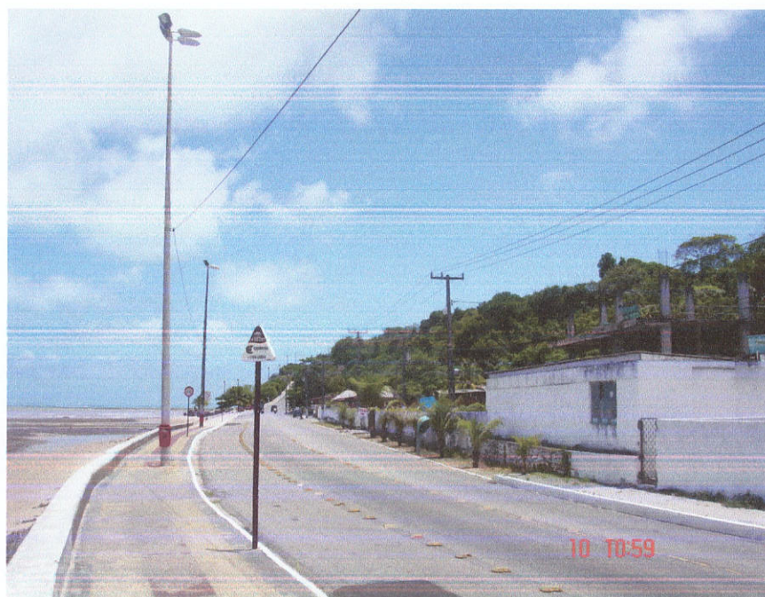
Fig. 26: Obras do Marina's Ocean à direita, de frente para o mar da Praia do Cabo Branco, com a falésia inativa, ainda visível, por trás.
