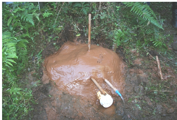
Figura 6: Aspecto de nascente d'água protegida pela técnica de cobertura com solo-cimento.
