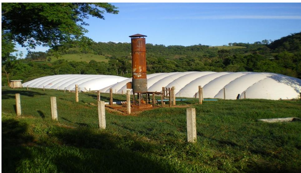
Figura 21 – Sistema de queima do biogás dos biodigestores. Fonte: autor, 2012.
