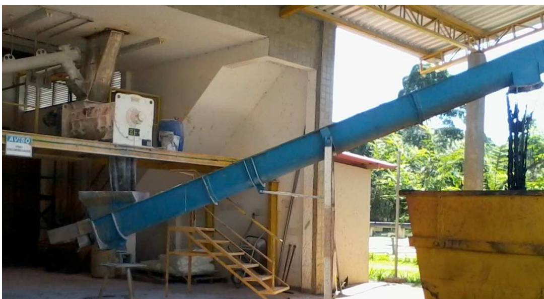
FIGURA 12 - MISTURADOR MECÂNICO DE CAL E LODO, ETE SANTA QUITÉRIA, CURITIBA, PR FONTE: O autor (2014)
