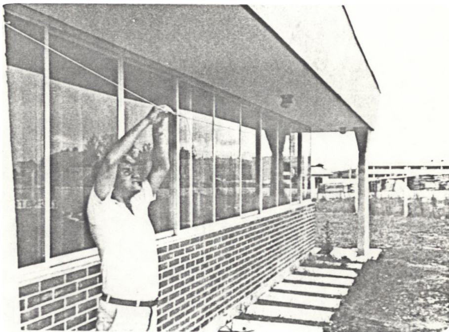
Foto 4 - Instalação da antena
