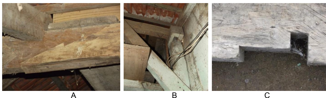
FIGURA 43 – SAMBLADURA USADA NA UNIÃO DE PEÇAS LONGITUDINAIS (A), CAIXA E ESPIGA NA UNIÃO DE PILAR E VIGA (B), PEÇA ENTALHADA (C).
