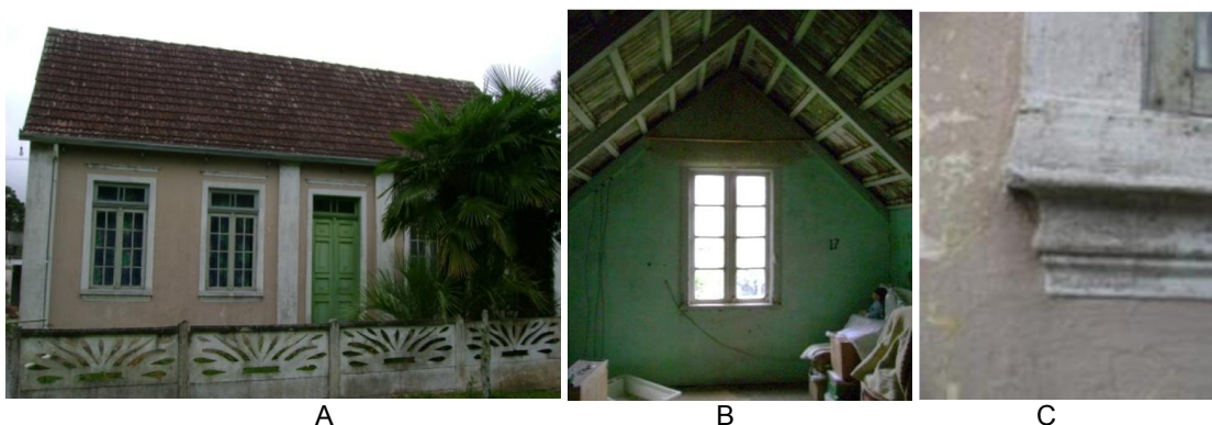
FIGURA 31 – FACHADA FRONTAL (A), VISTA DO SÓTÃO (B), DETALHE DA CIMALHA (C).
