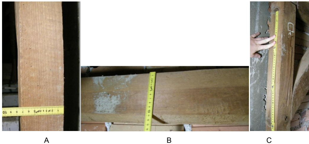
FIGURA 51 – ANÉIS DE CRESCIMENTO E GRÃ RETA NO PENDURAL PE6 (A), DISTINÇÃO ENTRE CERNE E ALBUNO BARROTE LADO ESQUERDO (B) NÓS VERTICILADOS PE2(C).
