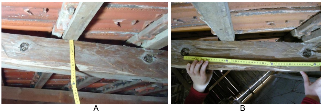
FIGURA 46 – NÓS VERTICILADOS NO CAIBRO CD3 (A), MEDIDA HORIZONTAL (B).
