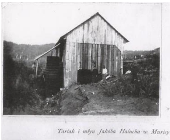
FIGURA 2 – MOINHO CONSTRUÍDO NA COLÔNIA MURICI (s.d.) FONTE: HOLTMAN, V.; HOLTMAN, V., 2012
