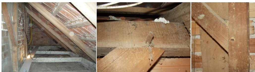
A B C FIGURA 41 – ESTRUTURA DA COBERTURA DA CASA DA CULTURA (A), MÃOS-FRANCESAS, ENCAIXE DO TIPO CAIXA E ESPIGA COM UNIÃO POR CAVILHA (B, C).
