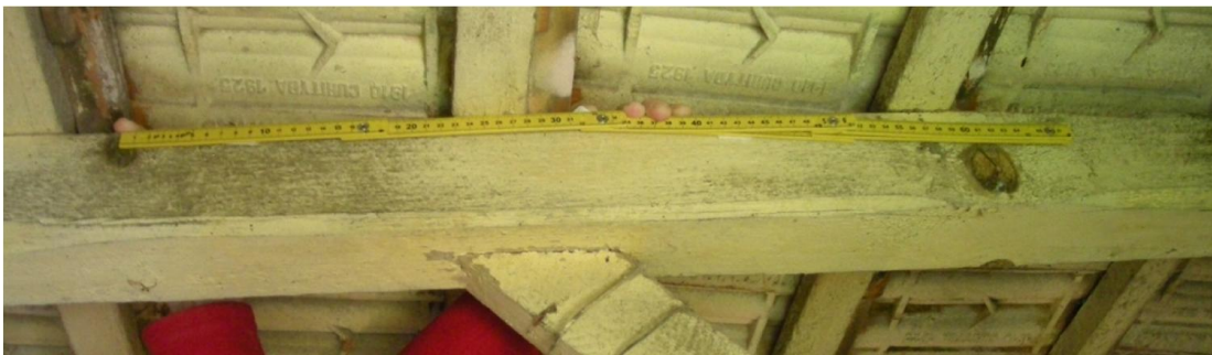
FIGURA 48 – PRESENÇA DE NÓS VERTICILADOS, DISTÂNCIA DE 60 cm - CAIBRO CE3.
