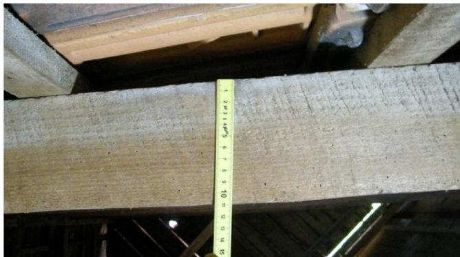
FIGURA 44 – CAIBRO CE7 COM DISTINÇÃO ENTRE CERNE E ALBURNO, GRÃ RETA.
