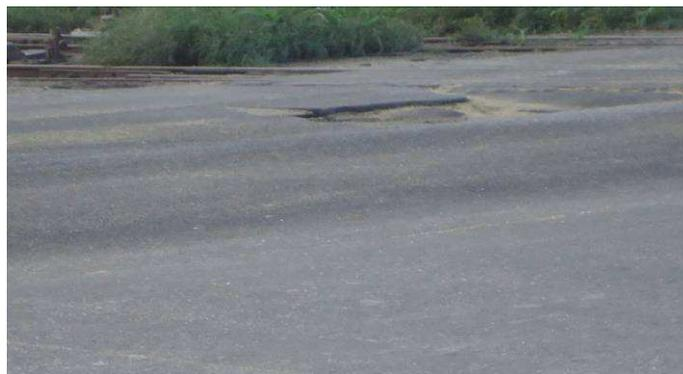
FIGURA 10. Rua de concreto degradada pelo excesso de peso dos caminhões.
