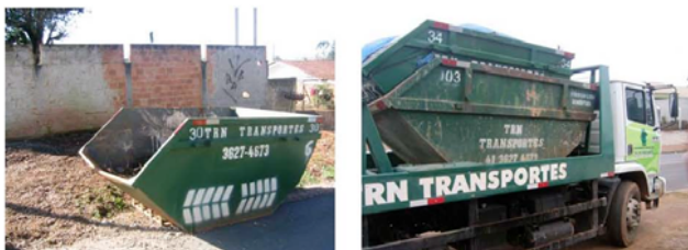
Figura 5-15: Caçamba para acondicionamento Figura 5-16: Transporte das caçambas de resíduos da construção civil.
