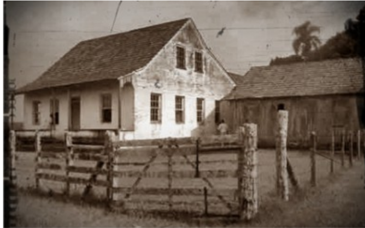
FOTOGRAFIA 7 - CASA ANTIGA EM FAZENDA RIO GRANDE
