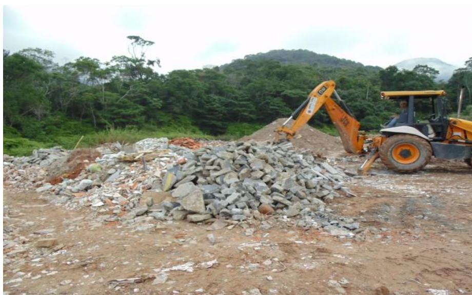
FIGURA 3 – RETROESCAVADEIRA, EMPILHANDO CALIÇAS FONTE: AS AUTORAS (2013).
