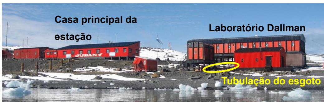
Figura 15 – Imagem da estação Carlini, do laboratório Dallman e da tubulação do esgoto durante a maré baixa (MAC CORMACK, comunicação pessoal ).
