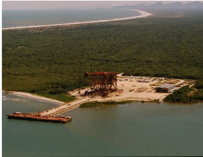
FIGURA 4: Canteiro de obras da Techint em 2006.
