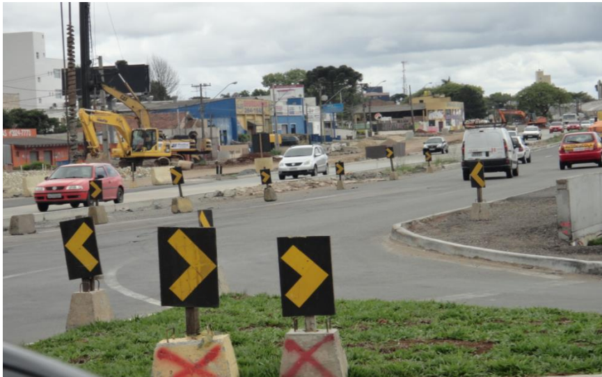
FIGURA 12 - OBRAS NA LINHA VERDE NORTE FONTE: A AUTORA, (2013)
