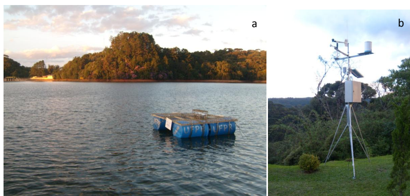
FIGURA 17: A) PLATAFORMA FLUTUANTE, B) ESTAÇÃO METEOROLÓGICA NO RESERVATÓRIO VOSSOROCA
