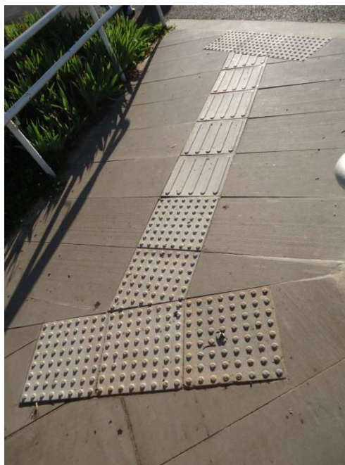
FIGURA 23 – PISO TÁTIL PRÓXIMO AO PAVILHÃO DE EVENTOS
