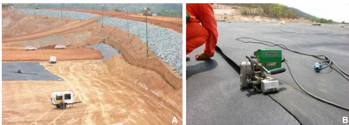
Figura 2.10 – Tapete impermeável a montante da barragem de São Salvador (CARDOSO et al. , 2010): (A) Instalação da geomembrana, e; (B) Execução de emendas
