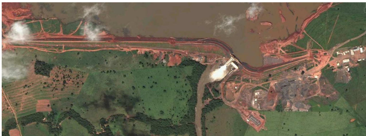
Figura 3.4 – Imagem aérea da UHE Salto (17/01/2010). Fonte: Google Earth (2014)
