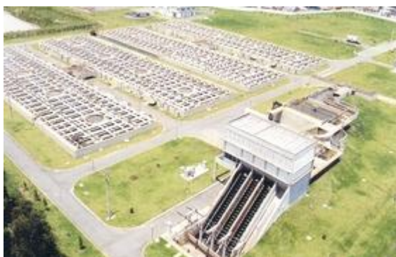
FIGURA 2.4 SISTEMA DE TRATAMENTO ANAERÓBIO ESTAÇÃO DE TRATAMENTO ATUBA SUL. CURITIBA. PR. Fonte: (Sanepar, 2010)
