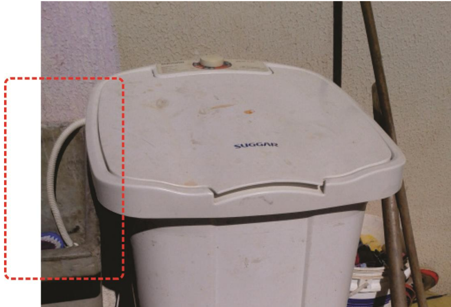
Figura 4. 15: Mangueira de saída de água conectada ao tanque (à esquerda).
