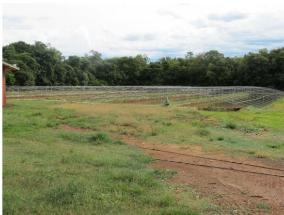
Figura 1. Tanques em fase terminal para instalação de estufa
