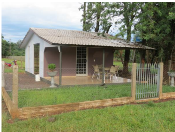
Figura 4. Escritório para atendimento a clientes
