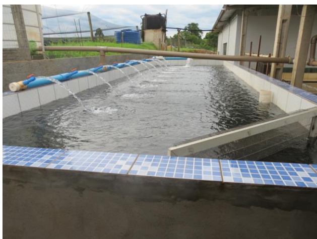
Figura 11. Tanque de depuração
