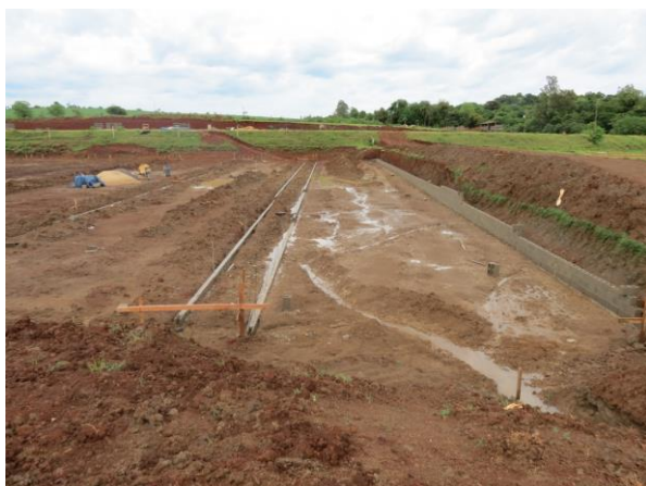
Figura 2. Tanques em construção
