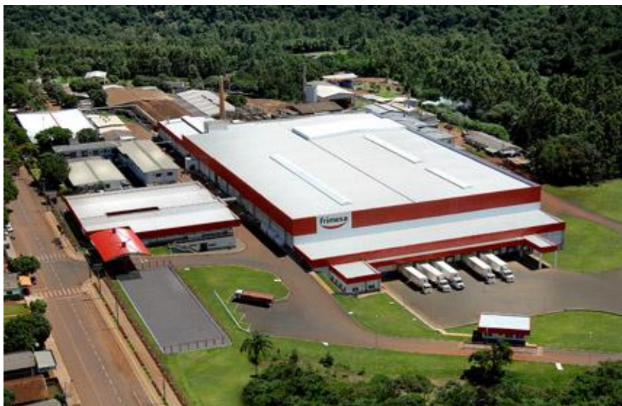
Figura 3: Abatedouro de Suínos Frimesa – Medianeira -PR
