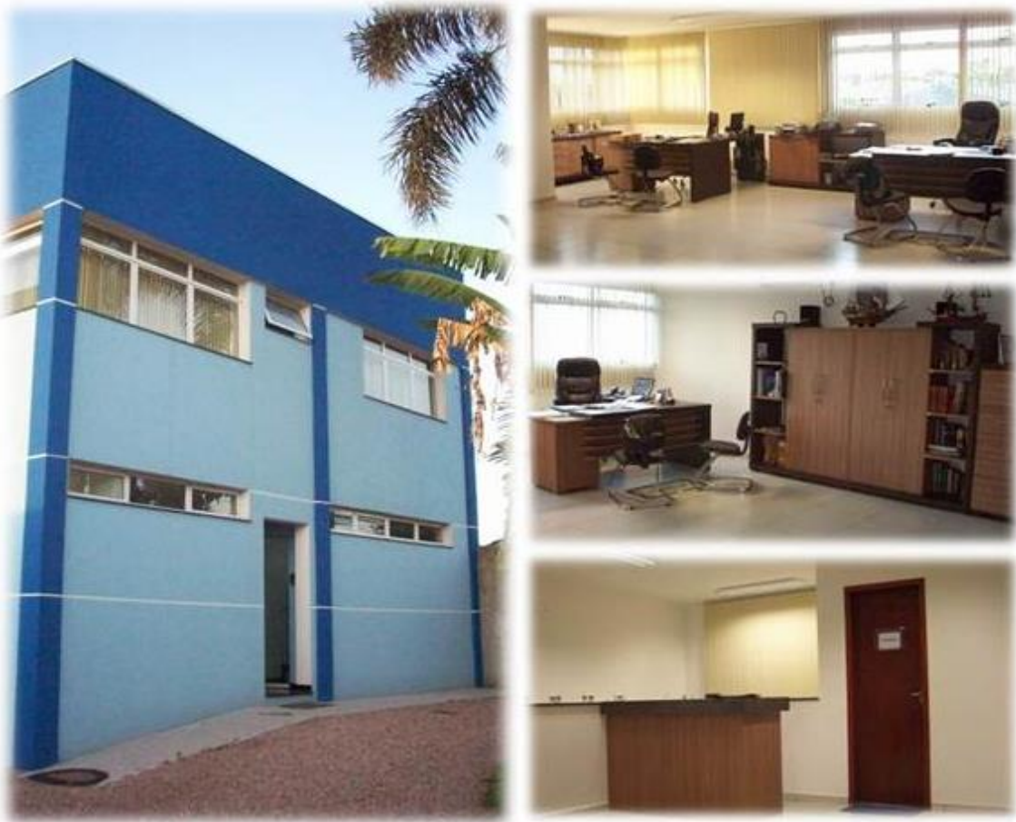
FIGURA 2 – NOVO ESCRITÓRIO OSG EMPREENDIMENTOS FONTE: AUTORAS, 2013.
