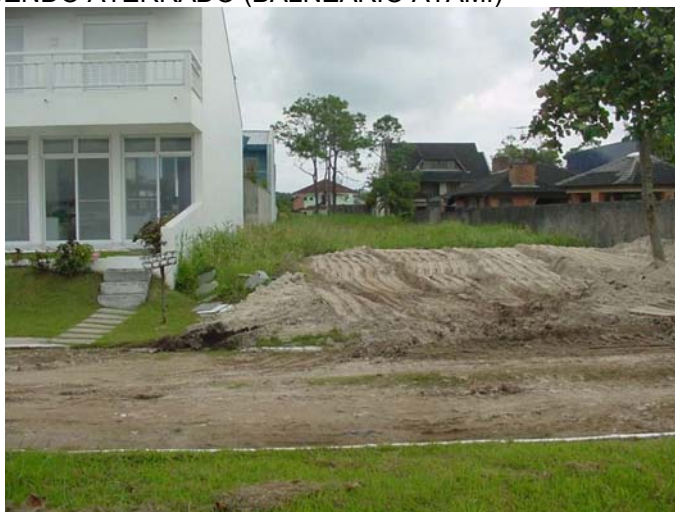
FIGURA 57 – LOTE SENDO ATERRADO (BALNEÁRIO ATAMI)
