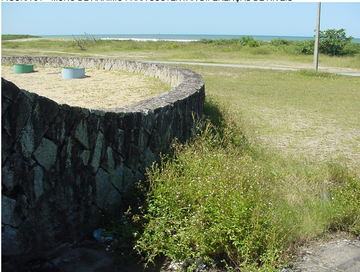
FIGURA 64 – MURO DE ARRIMO PARA SUSTENTAR DIFERENÇAS DE NÍVEIS
