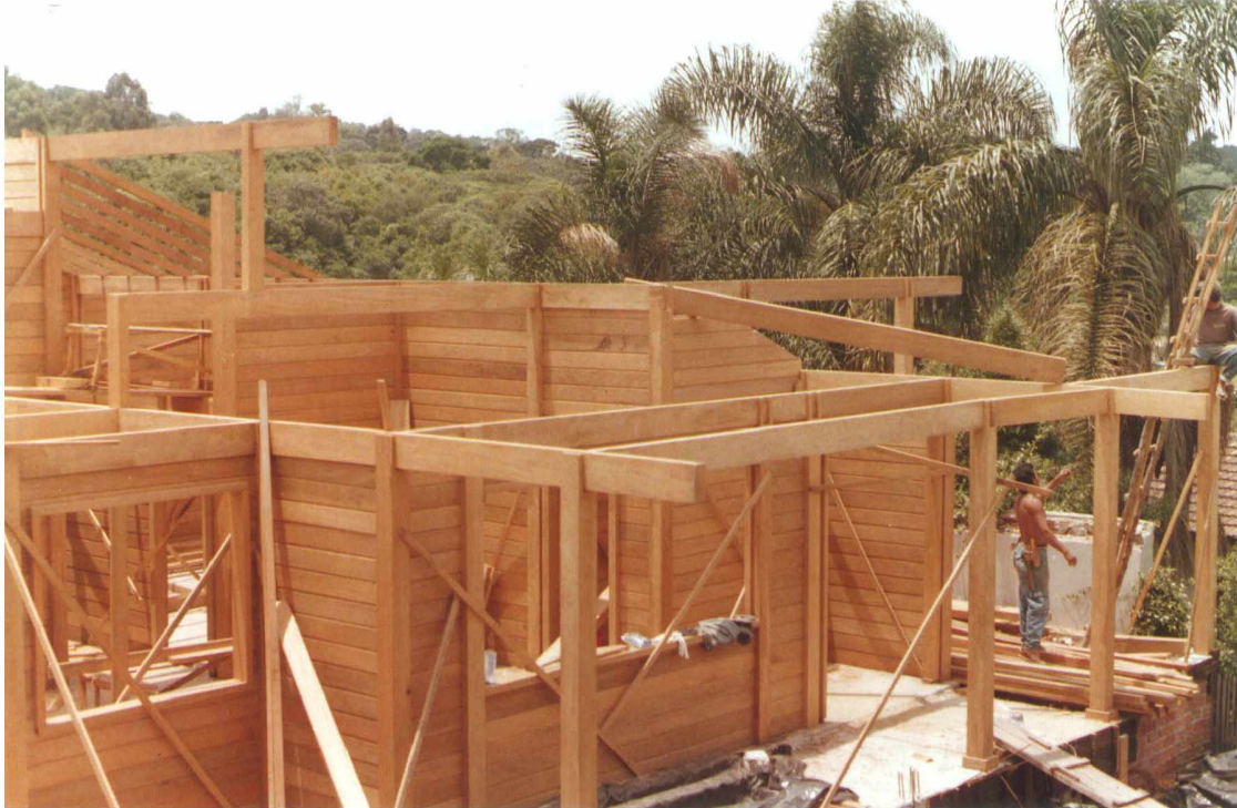
FIGURA 17-SISTEMA VIGA PILAR- MONTAGEM DAS VIGAS
