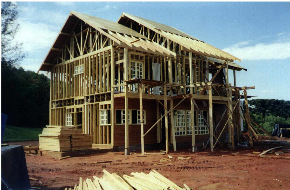
FIGURA18- SISTEMA CONSTRUTIVO TIPO PLATAFORMA OSSATURA
