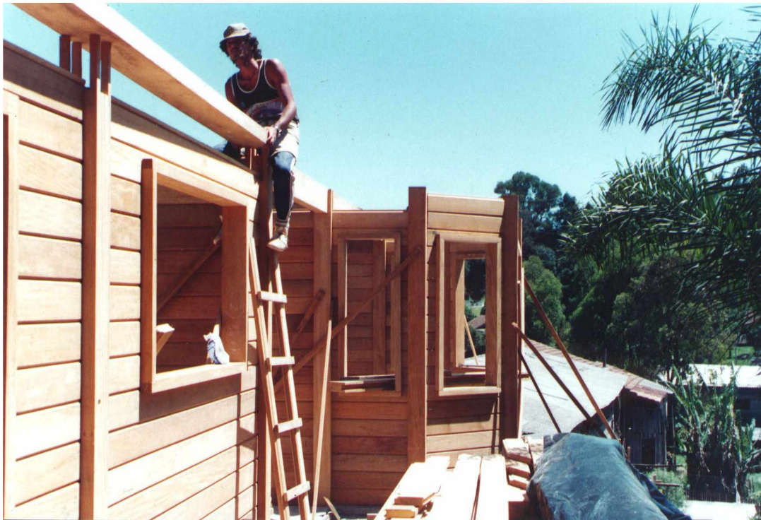
FIGURA 17-SISTEMA VIGA PILAR- MONTAGEM DAS VIGAS
