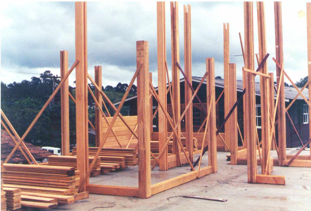
FIGURA 15 – SISTEMA VIGA- PILAR- MONTAGEM/ PILARES
