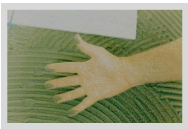
Figura 04: Argamassa industrializada com tempo de espera recomendado Fonte: Thomaz (s.d.)
