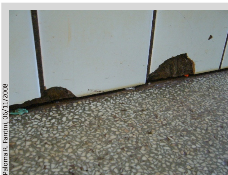
Figura 39: Detalhe do descolamento cerâmico – parte inferior da parede do bebedouro
