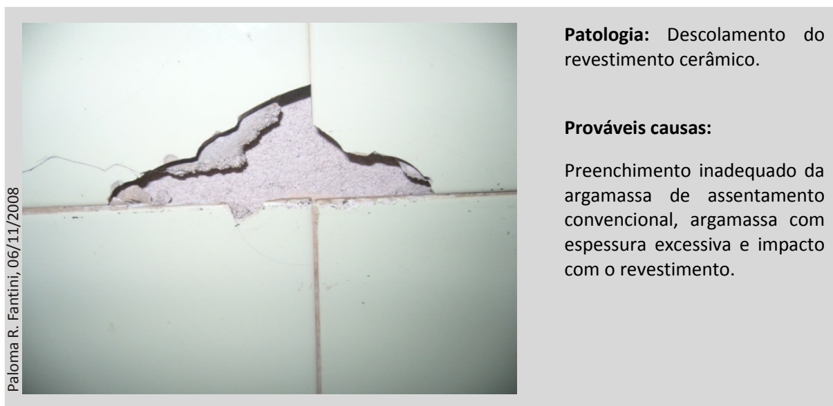
Figura 41: Detalhe do descolamento cerâmico – parede da cozinha
