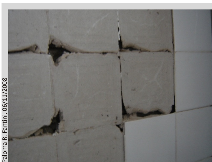
Figura 28: Detalhe do descolamento cerâmico – parede do banheiro
