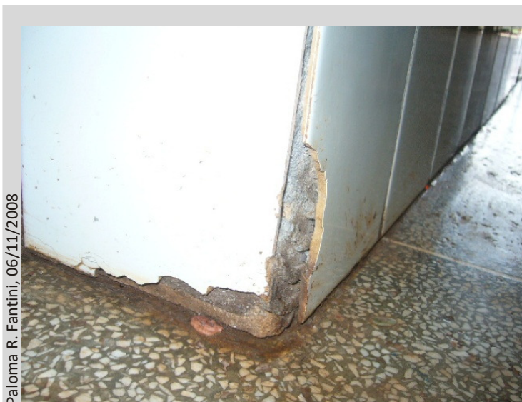
Figura 37: Detalhe do descolamento cerâmico – quina do bebedouro
