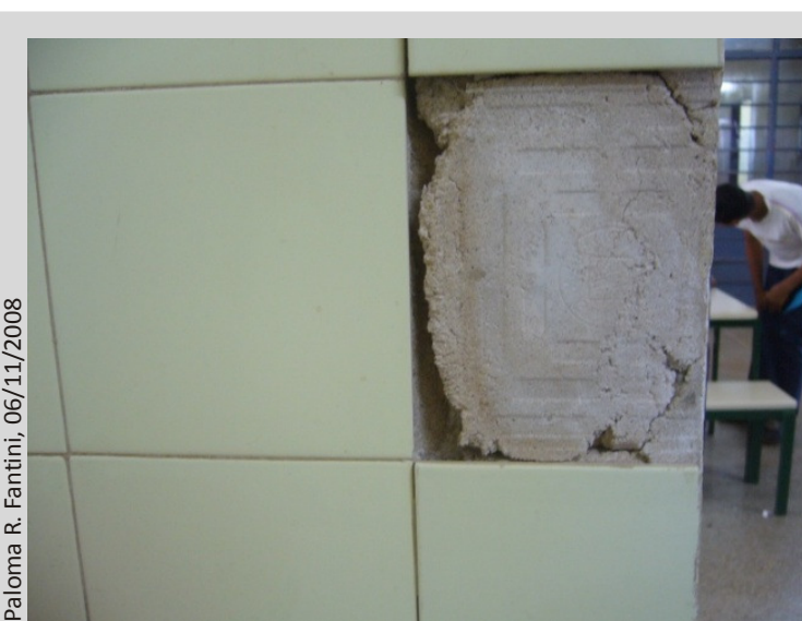
Figura 40: Detalhe do descolamento cerâmico – quina da parede da cozinha
