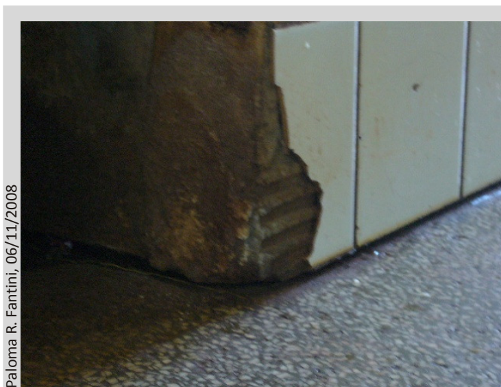
Figura 38: Detalhe do descolamento cerâmico – quina do bebedouro
