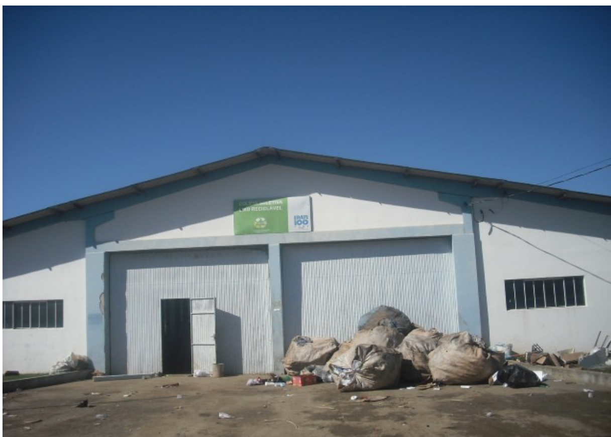
Figura 5- Barracão para a Cooperativa de Coleta e Reciclagem de Lixo
