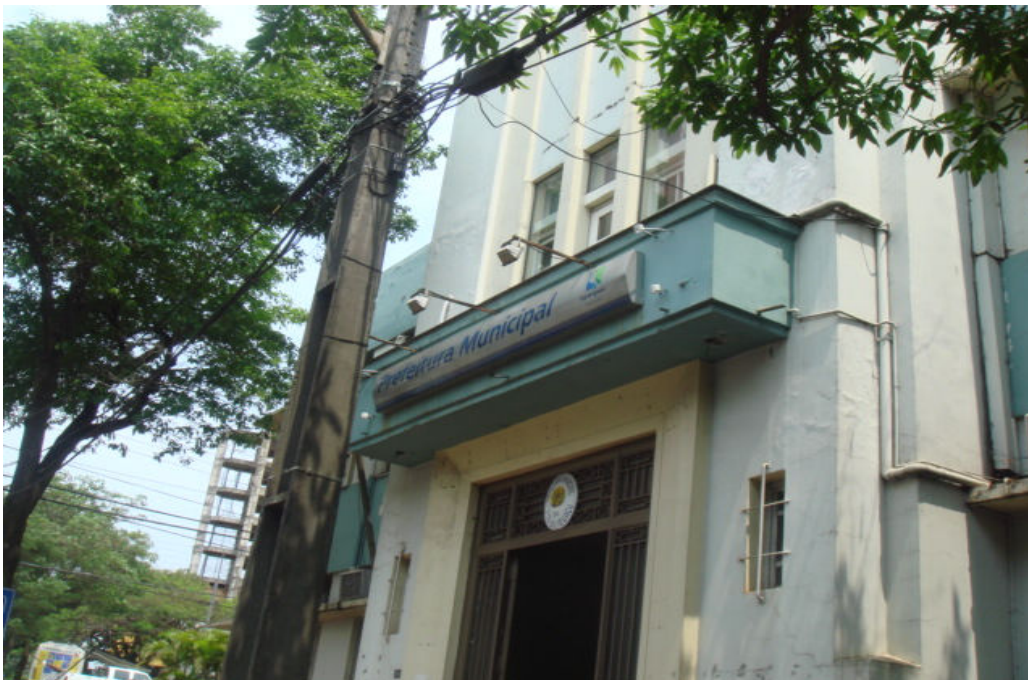
Figura 01: Fachada da Prefeitura Municipal de Foz do Iguaçu – Pr Fonte: autor
