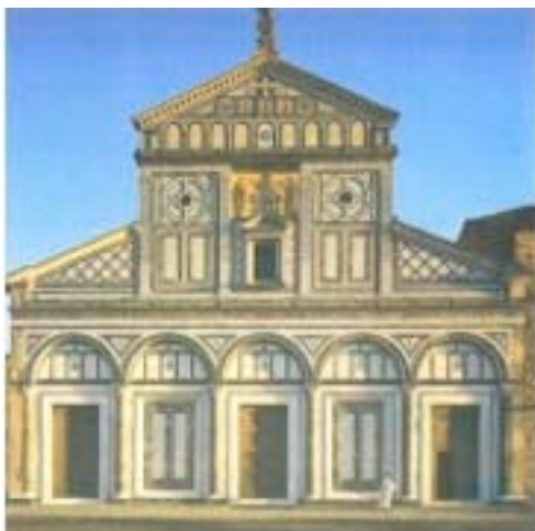
Fachada da Igreja de S. Miniato al Monte, Florença, Itália
