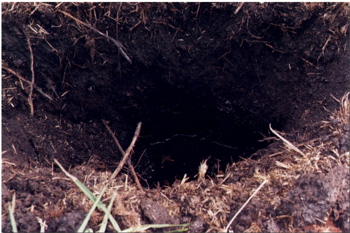
FIGURA 5 – DETALHE DA TRINCHEIRA ABERTA NO SOLO DE VÁRZEA
