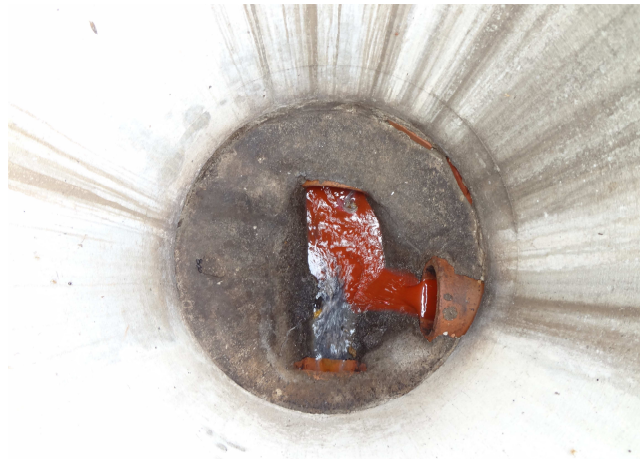
FIGURA 15 - FOTO DE POÇO DE VISITA DURANTE VISTORIA TÉCNICA AMBIENTAL FONTE: O autor (2012)
