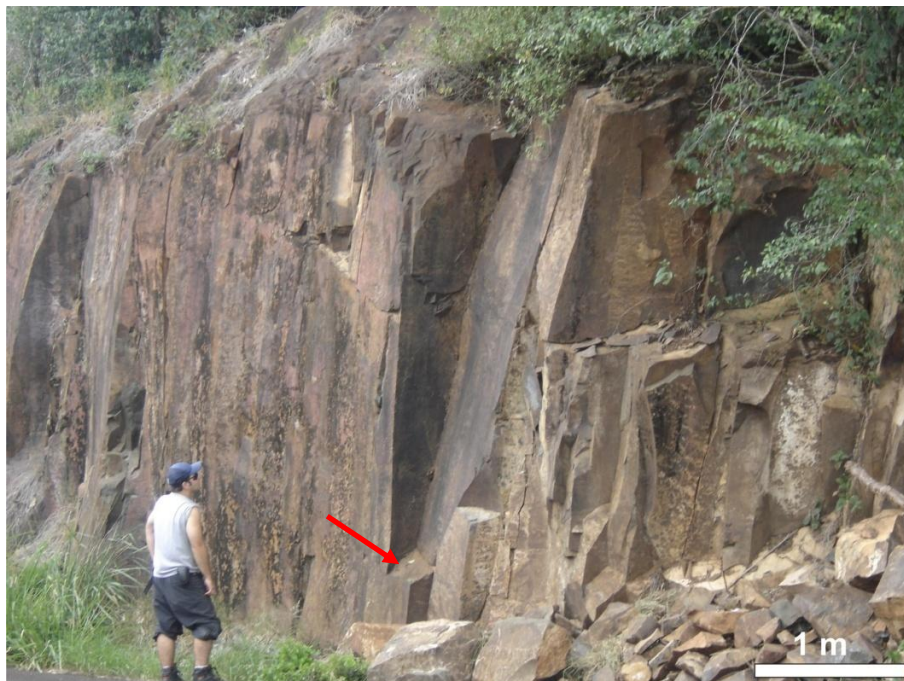
FIGURA 17 – FOTOGRAFIA DE SISTEMA DE FRATURAS REGULARES E CONTÍNUAS SUBVERTICAIS, DELIMITANDO PRISMAS COM ATÉ 4 LADOS (UM DELES É APONTADO PELA SETA VERMELHA) DA PORÇÃO MEDIANA-SUPERIOR DO NÍVEL MACIÇO CENTRAL
