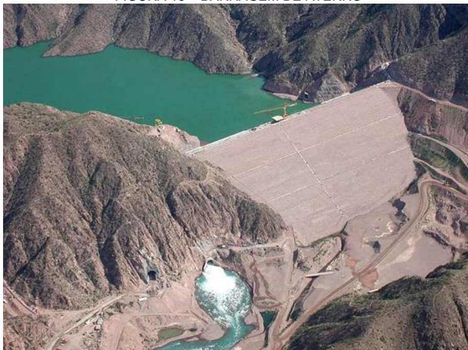
FIGURA 19 – BARRAGEM DE ATERRO
