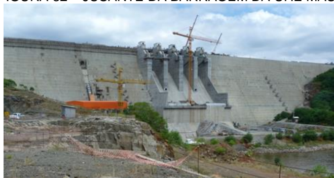
FIGURA 32 – JUSANTE DA BARRAGEM DA UHE MAUÁ
