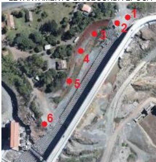
FIGURA 41 – LOCALIZAÇÃO APROXIMADA DOS PONTOS DE INSTALAÇÃO DO LST DO LEVANTAMENTO DA SEGUNDA ÉPOCA
