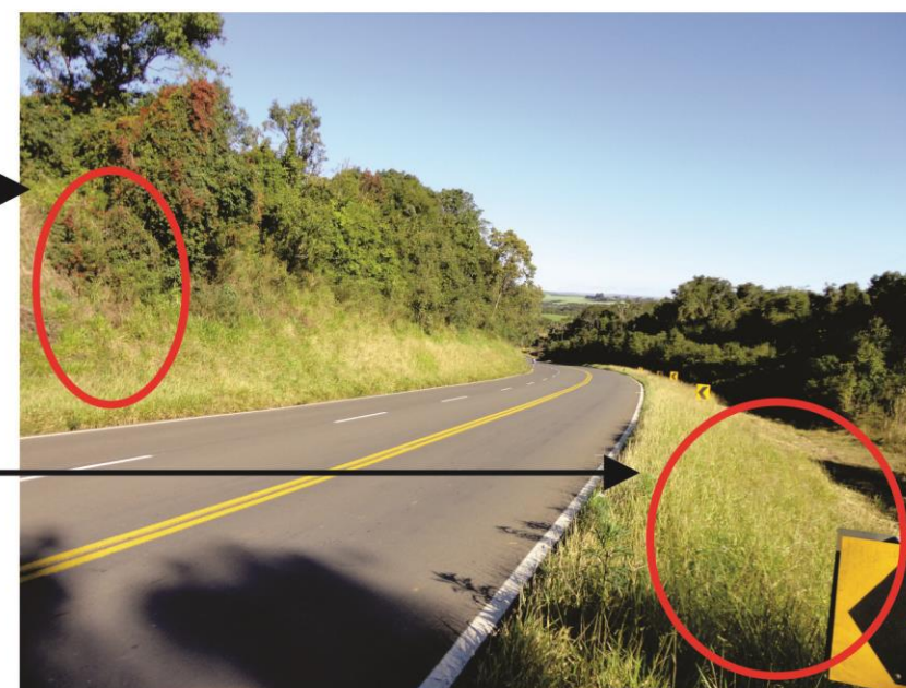
Foto 2. O afloramento Rio Guaricanga encontra-se em avançado estágio de alteração, com poucos metros de exposição de rochas. A porção inferior é observada do lado direito da foto, sentido Pirai do Sul, onde aflora na forma de lajedos na calha da rodovia, e do lado esquerdo, a porção média do afloramento é destacada pelas camadas arenosiltosas, sem acostamento.
