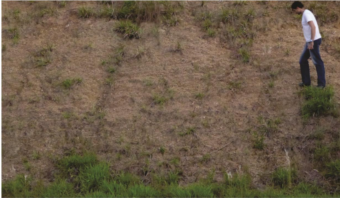
Foto 1. Vista geral dos folhelhos argilosos.
