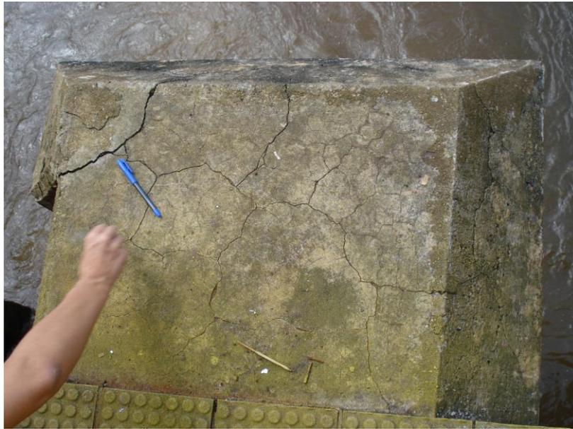
FIGURA 2: EXEMPLO DE FISSURAÇÃO CAUSADA PELA RAA - USINA HIDRELÉTRICA DE PETI
