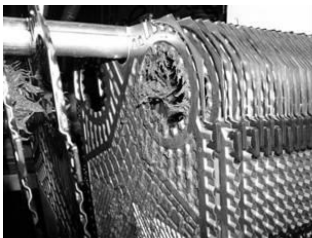
Figura 4 – Trocadores de calor da usina Governador José Richa tomados por colônias de C. caspia .
