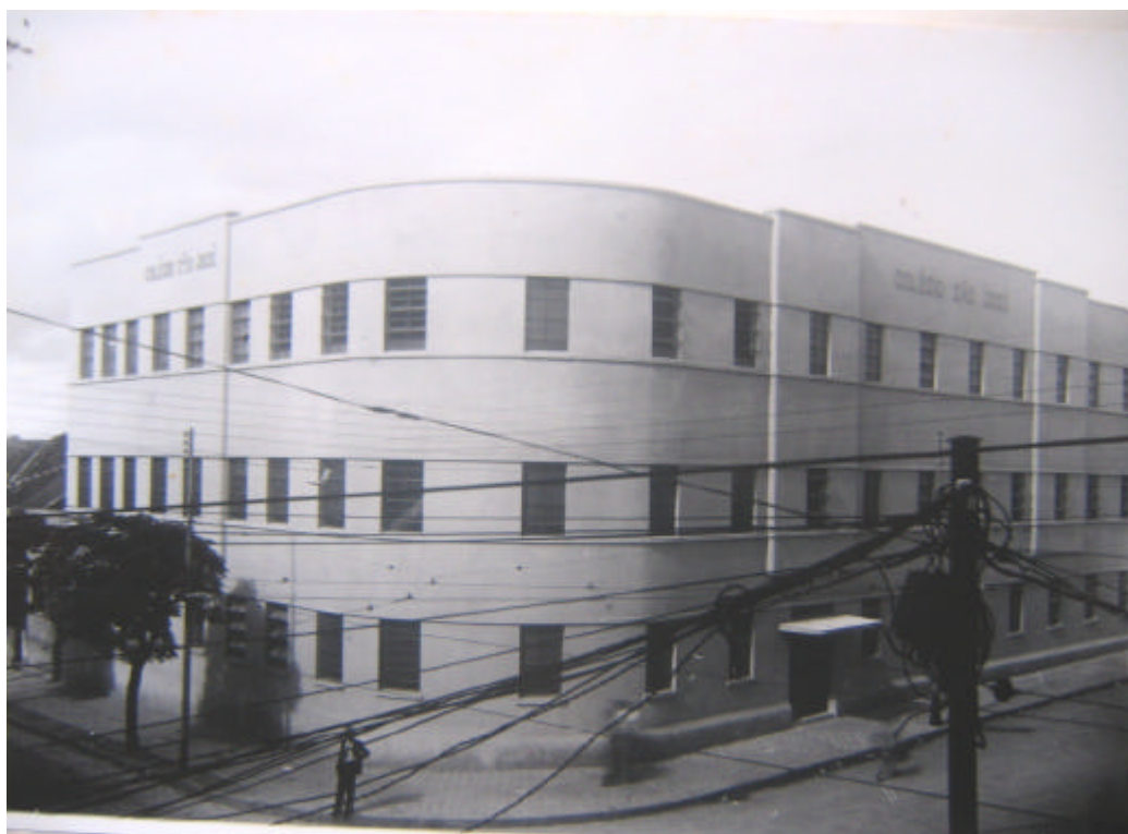
Figura 4 – Se o emaranhado da fiação da iluminação pública, da telefonia e mesmo do bonde elétrico, confunde a imagem das pessoas que passam ligeiras ao redor do novo prédio escolar, ele não escapa ao testemunho dos ‘novos tempos’ na cidade: a energia elétrica é cara a industrialização e a modernização da urbe. Curitiba, 1942.
