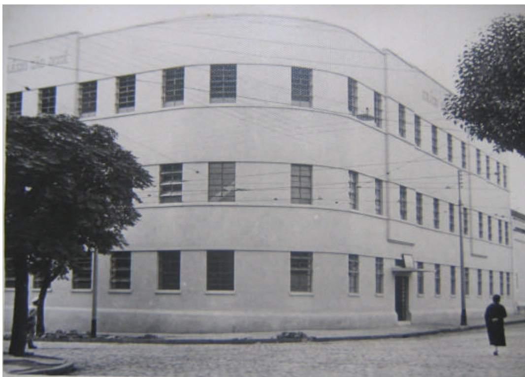
Figura 3 – Um guarda (esq.) e uma senhora (dir.) observam o novo prédio escolar, entre as esquinas das ruas centrais da cidade. À extrema direita, parte da edificação anterior. Curitiba, 1942.
